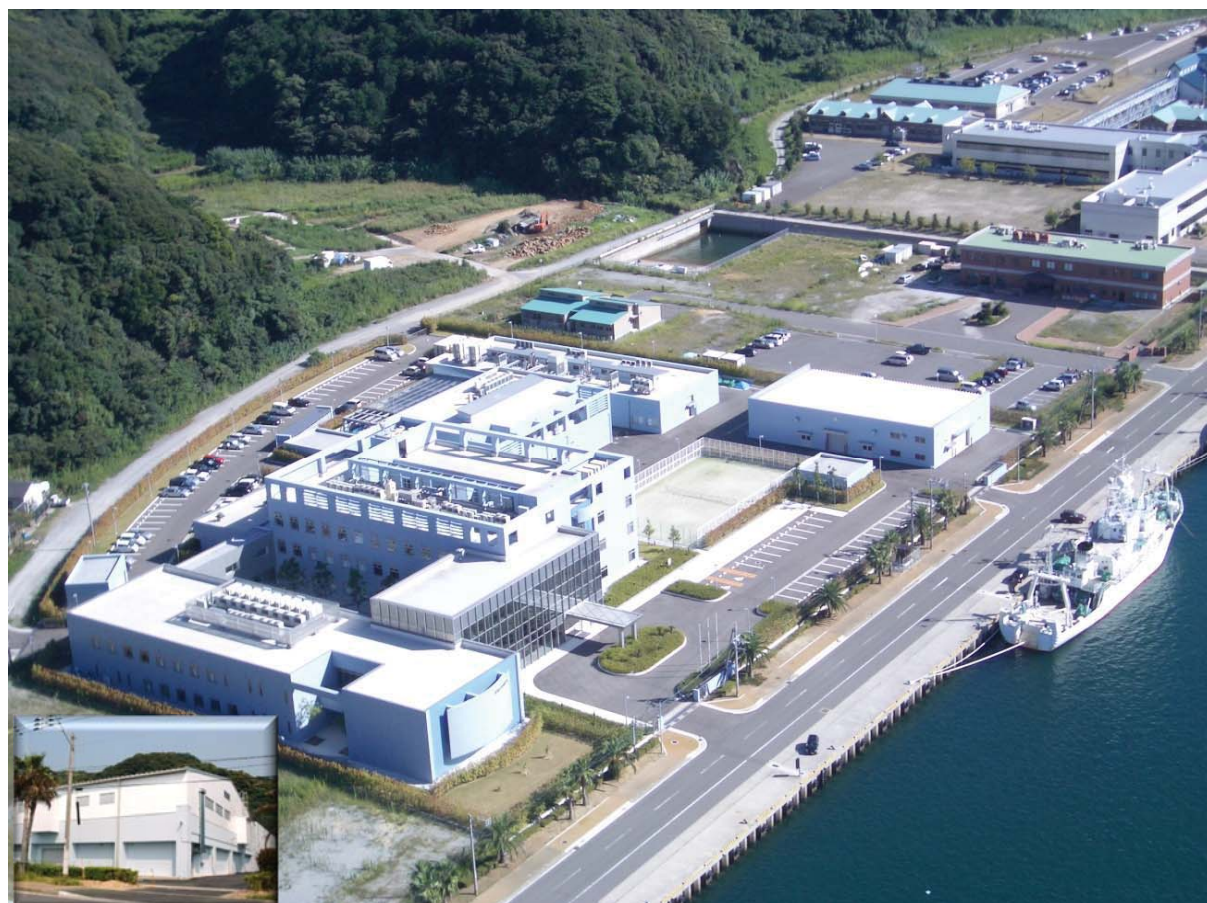
長崎庁舎外観写真(写真左下:まぐろ飼育研究施設外観)
